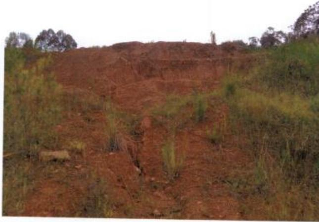
Figura 7: Vista em perspectiva de talude disforme formado por cava de mineração. Observa-se a formação de erosão em deposição de material desagregado em primeiro plano, indicando problemas no sistema de drenagem adotado para a operação.
