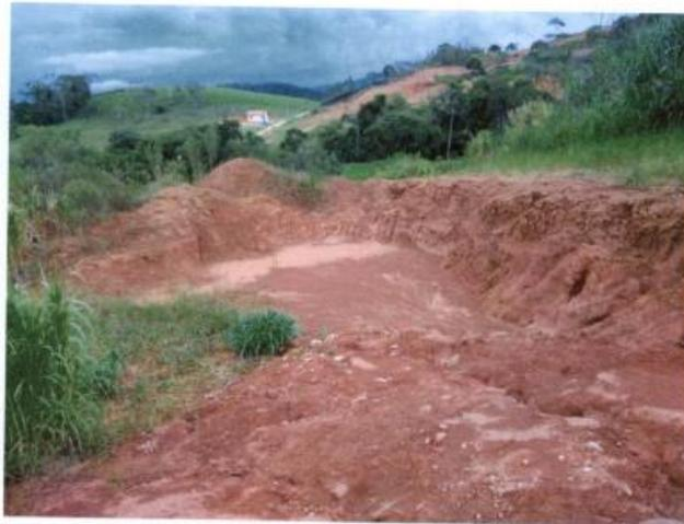
Figura 8: Vista de cava servindo de contenção de material particulado carreado por águas pluviais, formando depósito de material fino (lama seca).
