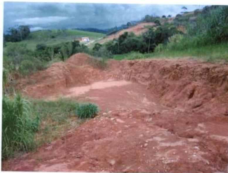
Figura 8: Vista de cava servindo de contenção de material particulado carregado por águas pluviais, formando depósito de material fino (lama seca).
