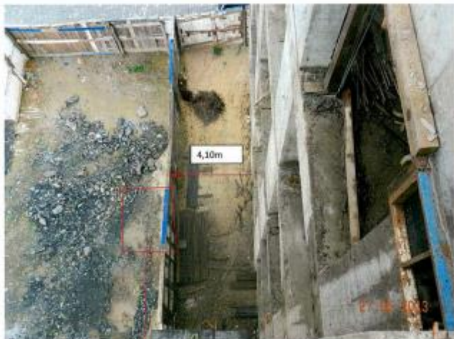
FOTOGRAFIA REALIZADA DO TOPO DO PRÉDIO
